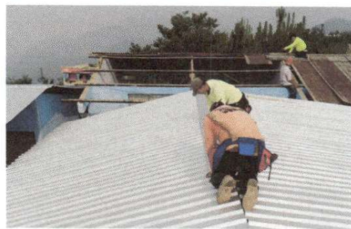
Foto 4: Sustitución de laminas
