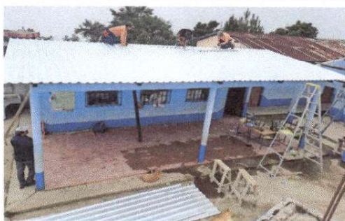
Foto 3: Cambio de techos
